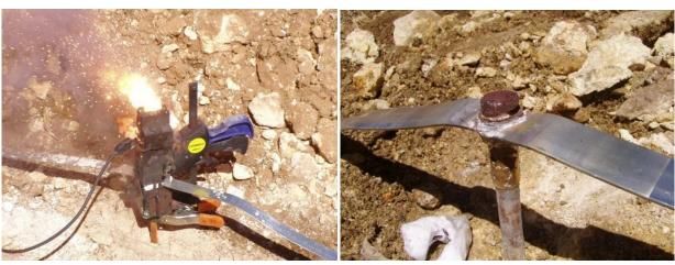
Figure 20 Soudage aluminothermique
