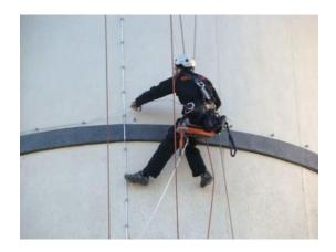
Figure 13 Installation du ceinturage
